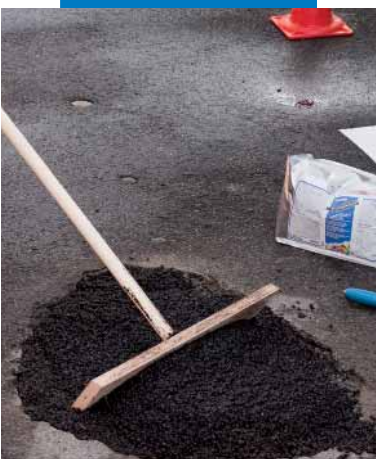
Aplikace a rozprostření Mape-Asfaltu Repair 0/8
