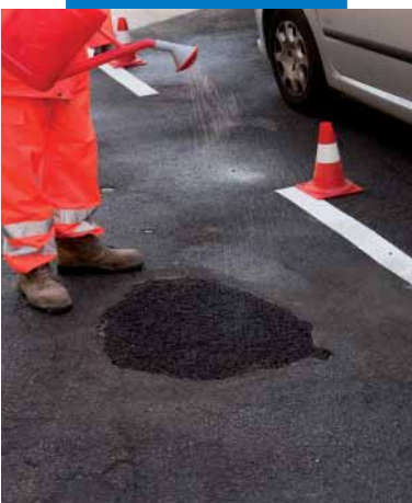
Vlhčení povrchu Mape-Asfaltu Repair 0/8
