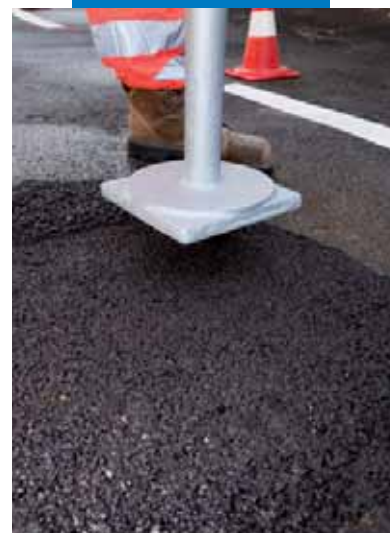
Ruční hutnění Mape-Asfaltu Repair 0/8
